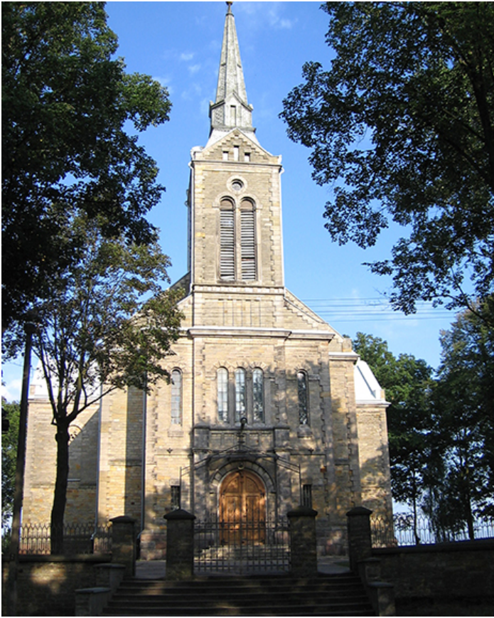
Kościół w Kraśnicy, fot. arch. autorki
