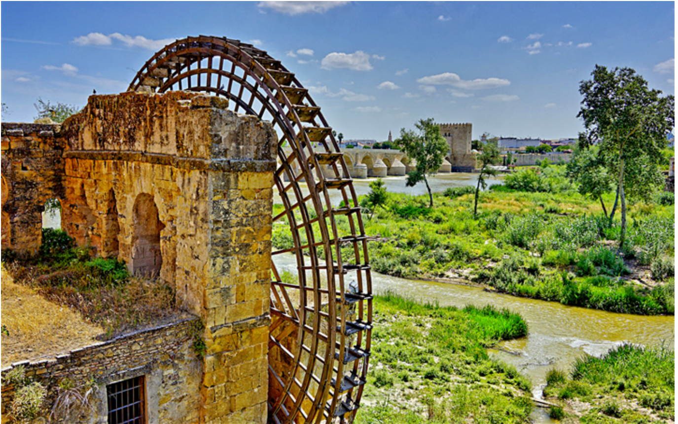
Kordowa. Noria (arabski czerpak mechaniczny do wody)
