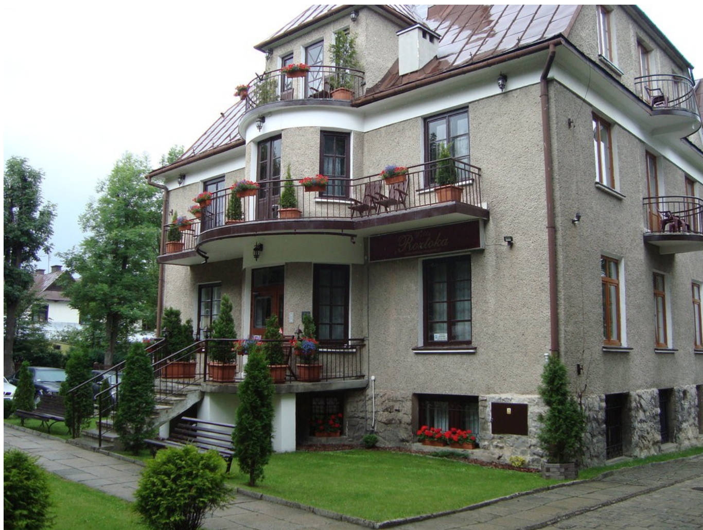
Zakopane, Pensjonat Roztoka, kedyś Zawory.
