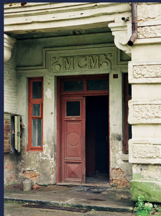
wejście główne z datą rzymskimi cyframi „1900” fot. W. Żurawski 2007 r.
