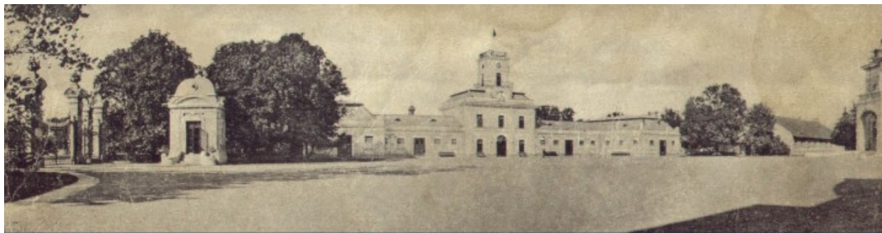
Antoniny - widok na stajnie od strony pałacu, po lewej brama główna i „szwajcarka” (kordegarda)
