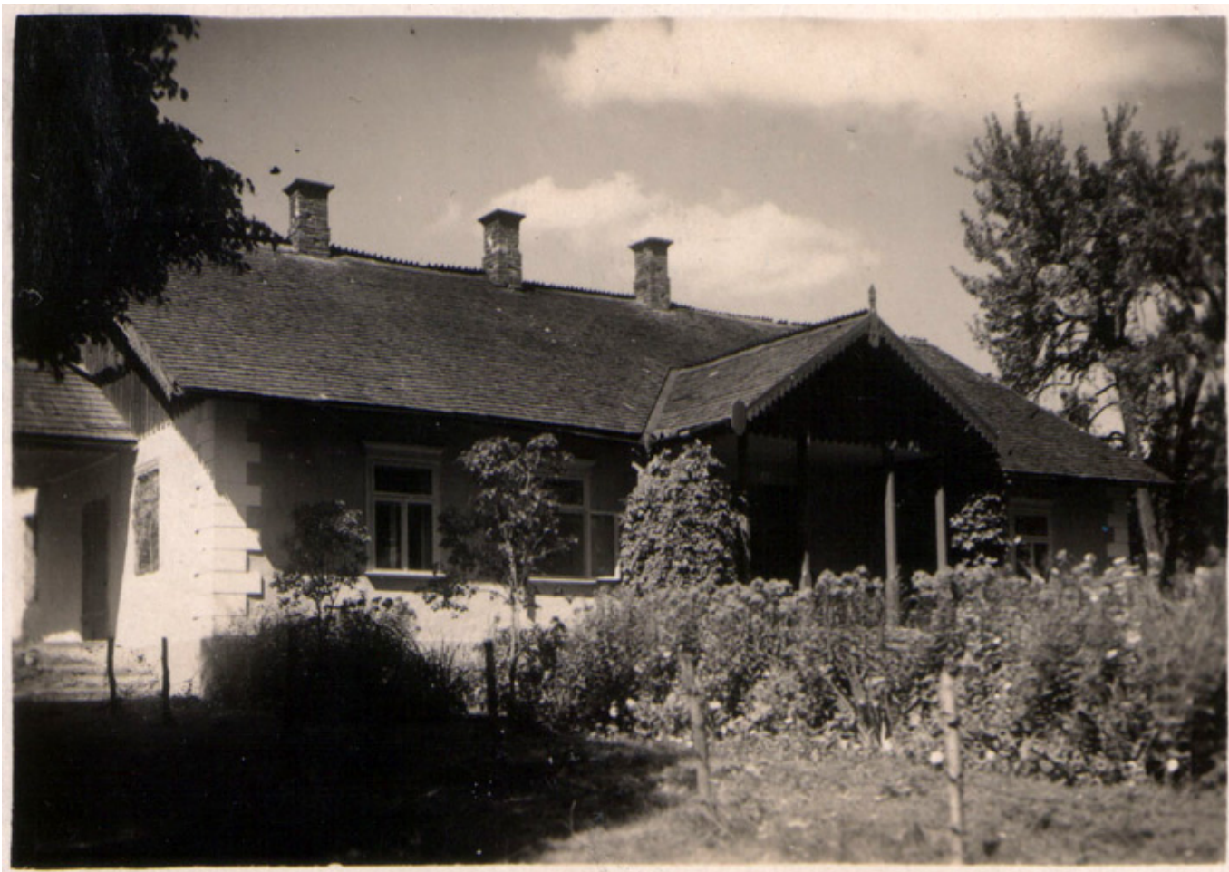
Barysz, dom Aliny i Leopoldyny Korzeniowskich, fot. arch. R. Sawickiego.
