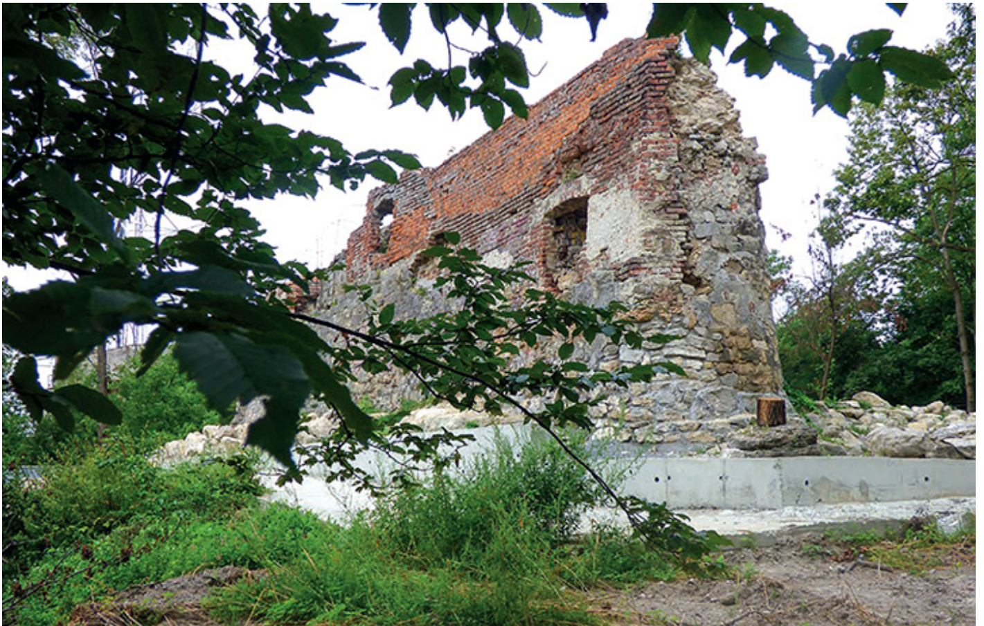
Ruiny murów obronnych Wysokiego Zamku
