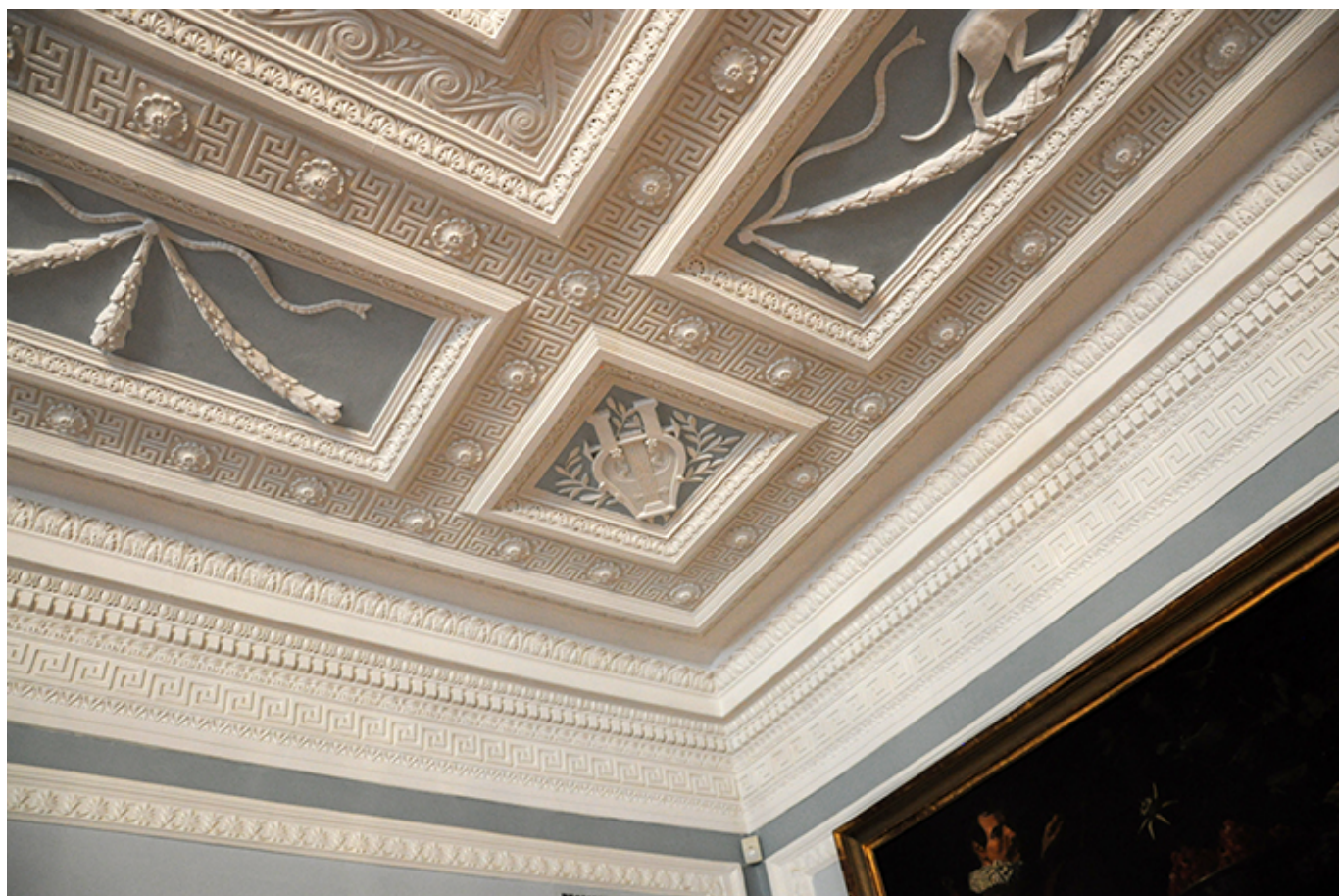
Pałac Tyszkiewiczów w Kretyndze, strop, fot. Wrzesław Żurawski
